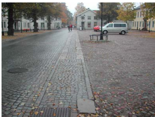
Foto 8: Exempel på mycket ojämn beläggning
